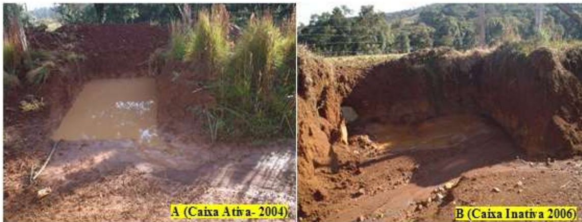
Figura 7- Comparação das caixas de infiltração no período em atividade e no período em que já estavam deterioradas (desmoronamento das laterais). Em A, caixa de infiltração ativa retendo água e sedimentos produzidos, sobretudo nas estradas rurais, em B caixa de infiltração inativa sem condições de reter a água e sedimentos. Foto dos autores (2004-2006).
